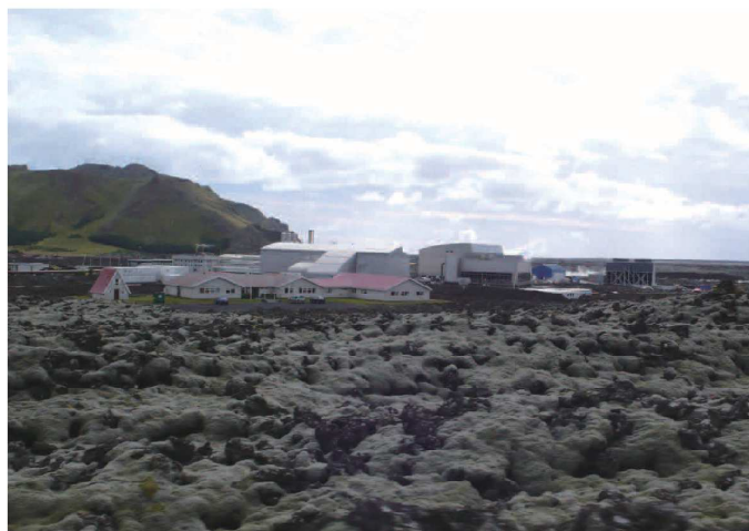
ブルーラグーン発電所
